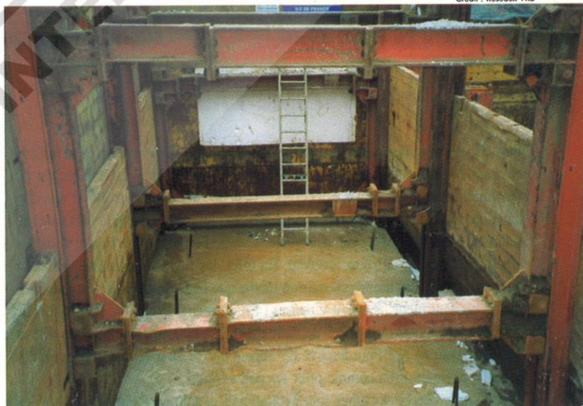
On voit bien ici le système à double glissières de Krings. Une fois la cuve posée sur la dalle de béton, le remblaiement pourra commencer en enlevant la plaque la plus basse tandis que la plaque haute continuera à blinder l'ouvrage.
