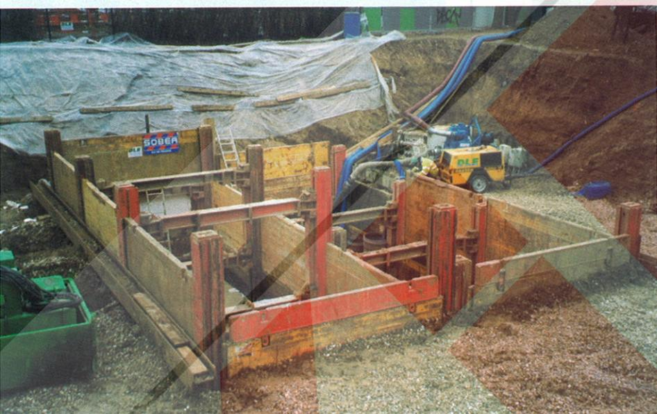
Le chantier, situé en contrebas de la RN7 est une fosse de 10 mètres sur 7 mètres dans laquelle vont être installées deux cuves pour récupérer les rejets pluviaux de la route et ainsi lutter contre la pollution du lac tout proche.
